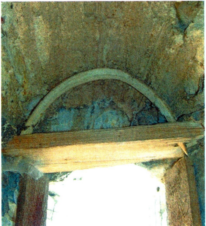
Im Stephansturm in Ensdorf findet sich ein Fenster mit einem 1000 Jahre altem Weidenzweig zur Bogenmarkierung. Foto: Röttenbacher
